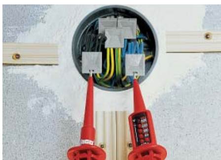
Проверка напряжения в клеммах для распределительных коробок
